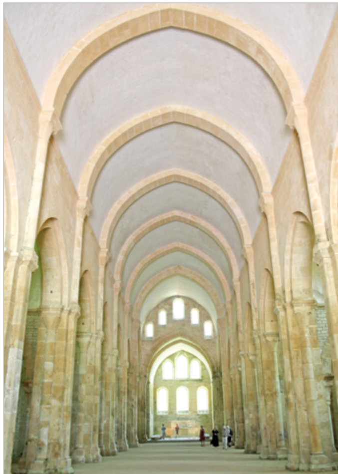
Im weiten Kirchenraum der Abbaye Fontenay wird der Blick nach oben zu den mächtigen Quergurten und dem einfachen Spitztonnengewölbe gezogen.
